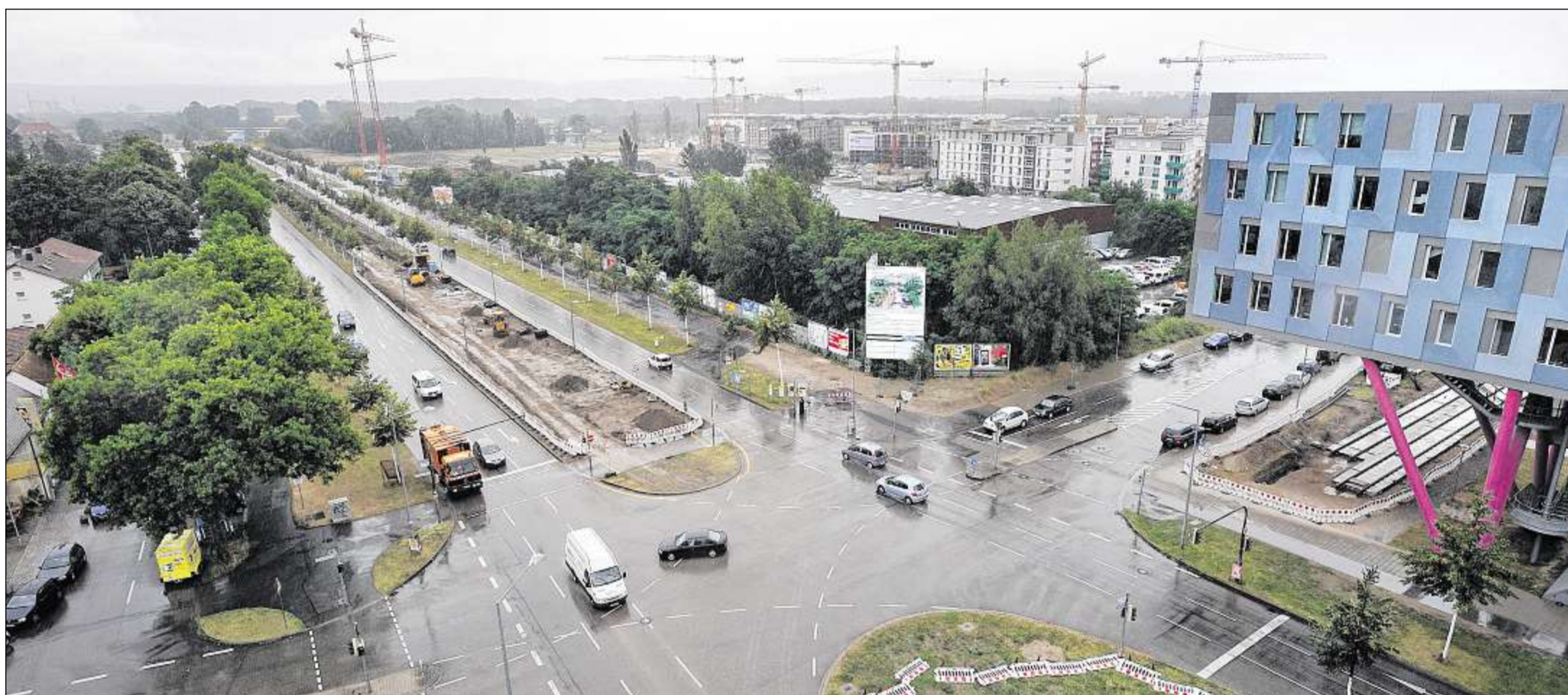
MIT „KARLSRUHE SÜDOST“ ist die Südstadt zur Boomtown geworden, denn zu ihrem Territorium gehört das Baugebiet mit der rasanten Entwicklung. Jetzt hat ein Investor auch die zwei Bauplätze zwischen der LBBW (rechts) und seinem Hochhausprojekt „Park Office“ (die zwei Kräne links) gekauft. Er will am Erhardboulevard auch dort schnell bauen, im Hintergrund Wohnhäuser von „Südost“. Foto: Alàbiso
